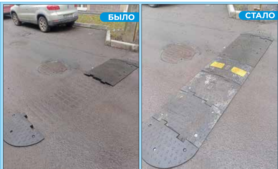
Восстановление искусственной неровности на пр. Стачек, 216.
