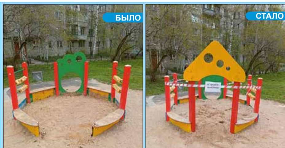
Дачный пр., 23, корп. 1. Ремонт и окраска песочницы на детской площадке.
