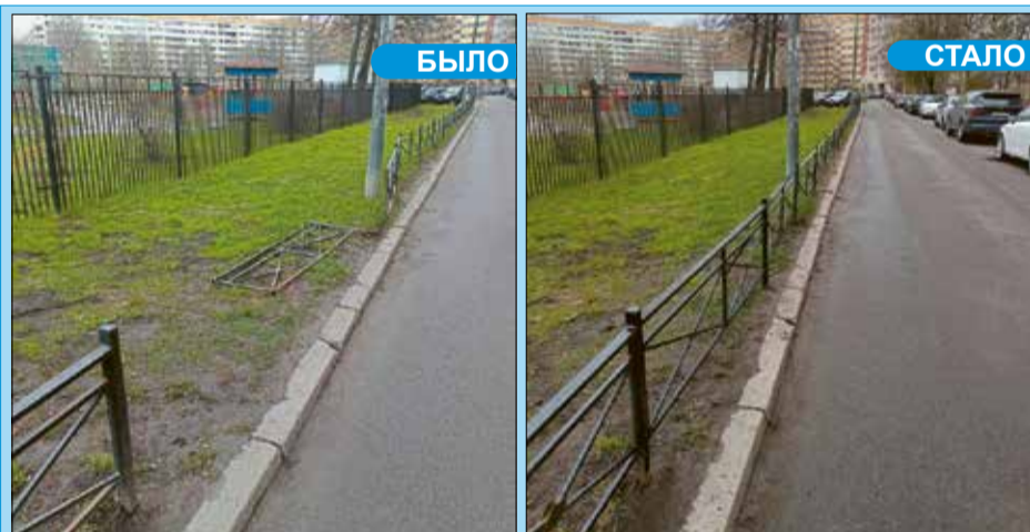
Пр. Ветеранов, 1, корп. 1. Ремонт газонных ограждений.
