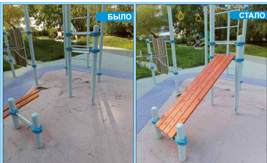
Ленинский пр., 118. Ремонт игрового оборудования.
