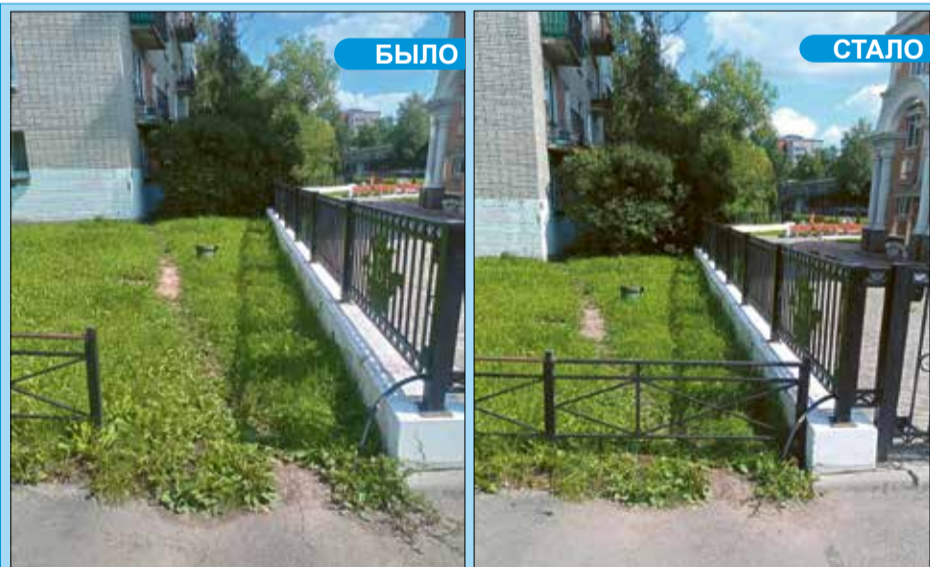
ул. Лени Голикова, 15. Ремонт газонных ограждений.
